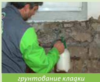
грунтование бетона
