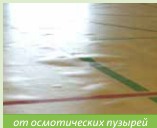
нанесение на 7-дневный бетон
