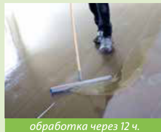
нанесение на 7-дневный бетон
