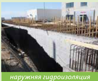
гидроизоляция фундамента
