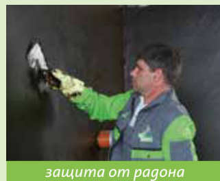
гидроизоляция фундамента
