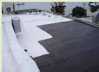
нанесение на битум
