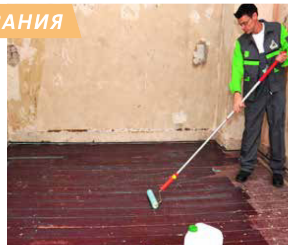
Грунтование деревянного пола с применением КЁСТЕР ВАП И Об Primer
